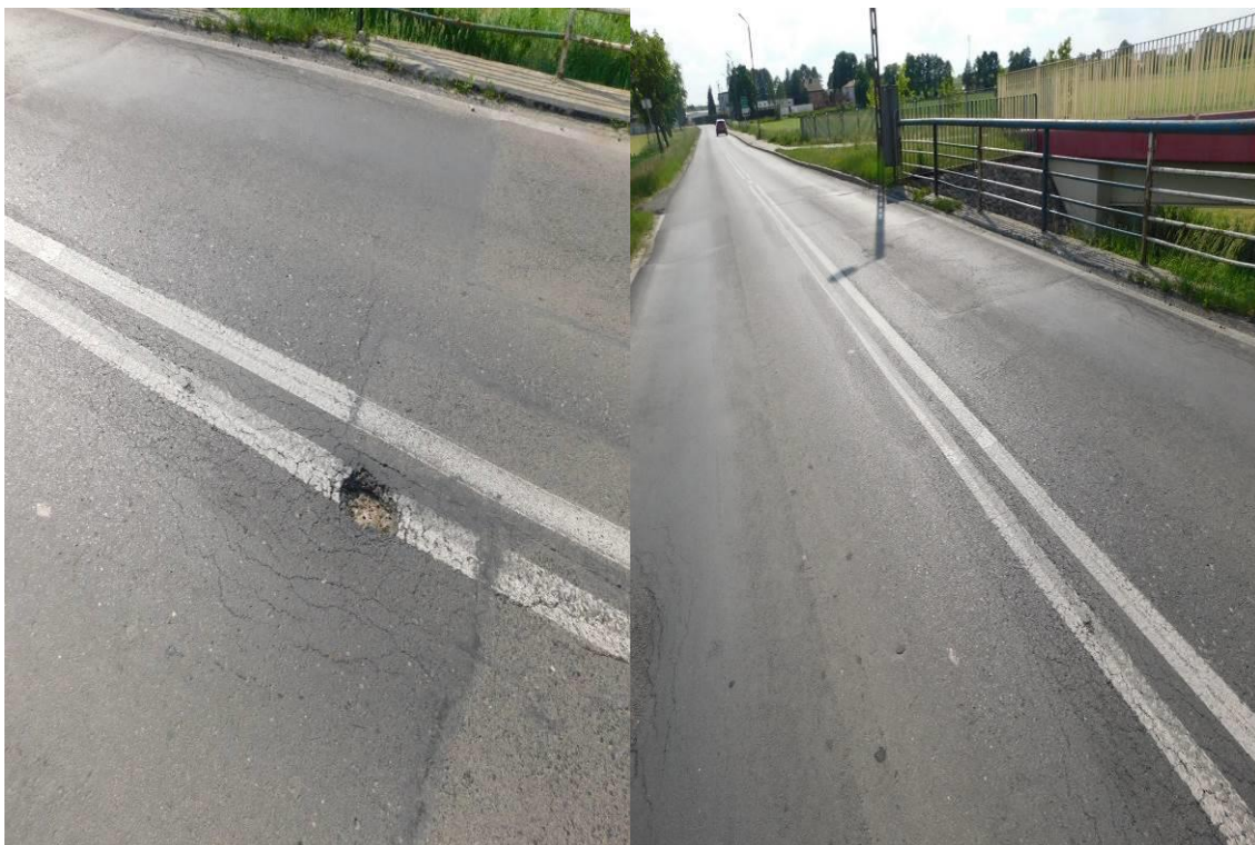
Fot. 7. Deformacje nawierzchni (skoleinowania), różnokierunkowe spękania w obrębie środka jezdni oraz ubytek nawierzchni – widok od strony Kuluszek
