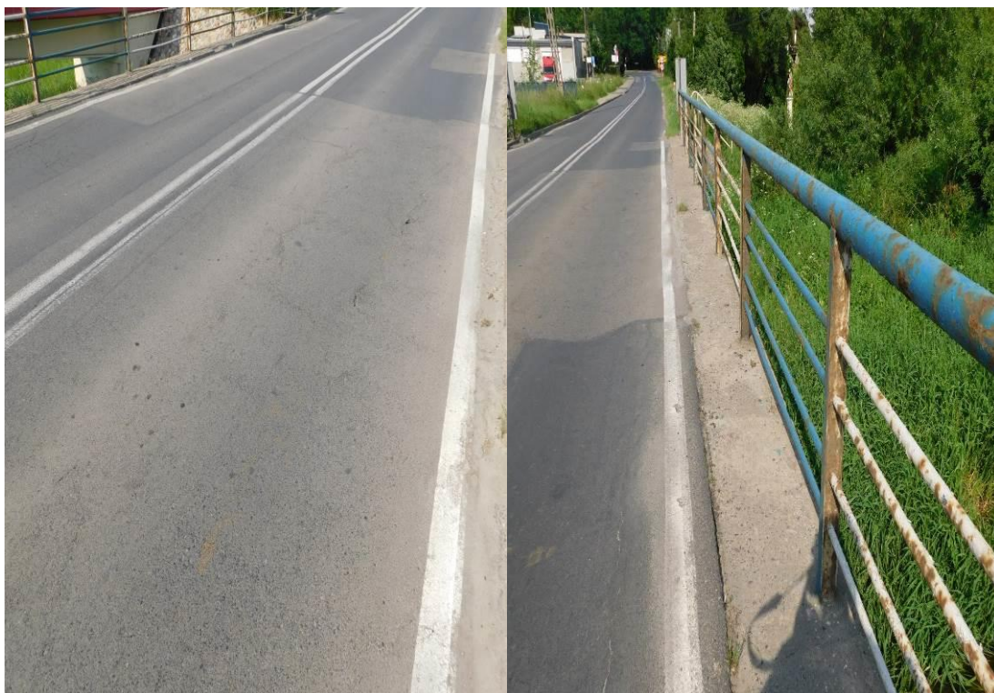
Fot. 9. Spękania na nawierzchni jezdni. Ubytki i spękania betonu belek podporęczowych. Zniszczenie powłok antykorozyjnych na balustradach wraz z towarzyszącymi im ogniskami korozji - od strony GW
