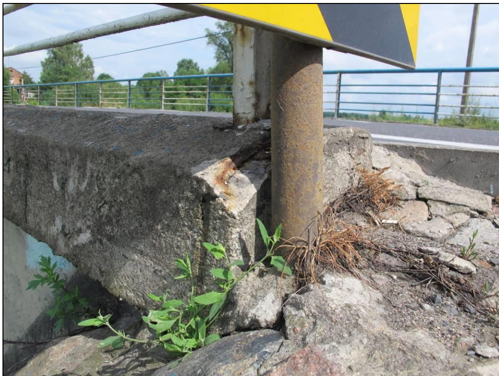
Fot. 11. Ubytki betonu belki podporęczowej wraz z odsłoniętym korodującym zbrojeniem - od strony Piotrkowa Trybunalskiego GW
