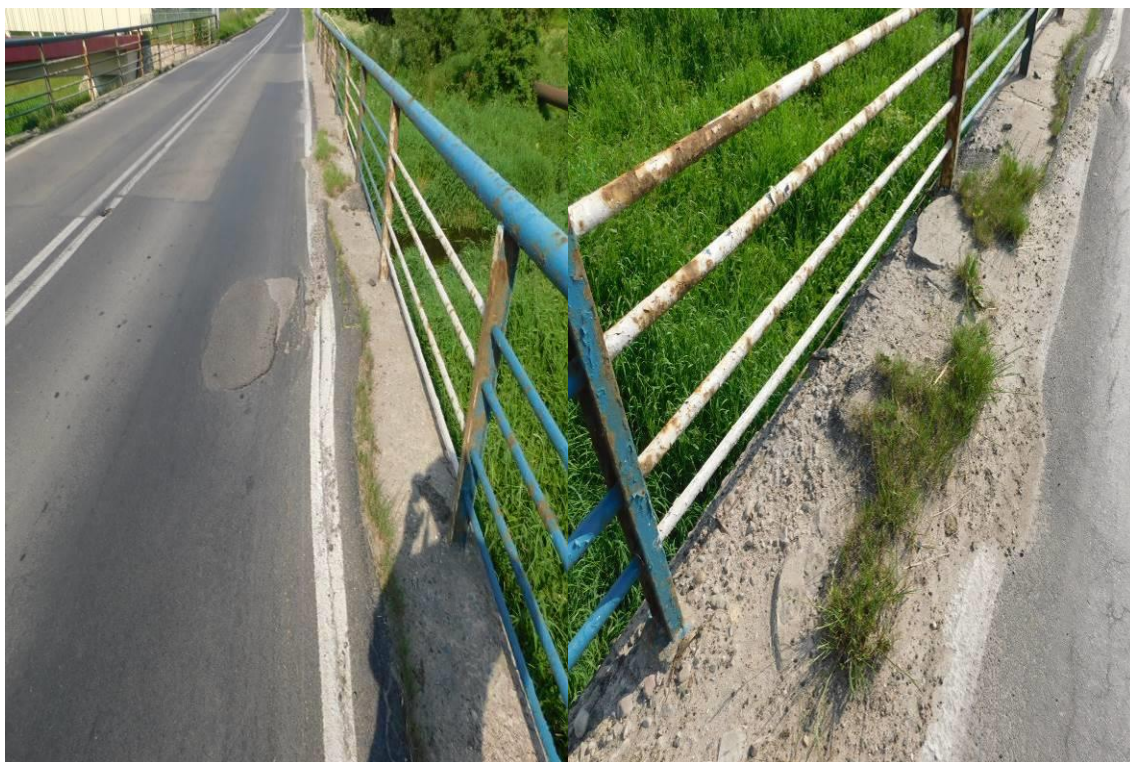
Fot. 6. Spękania na nawierzchni jezdni. Widoczne deformacje i ubytek nawierzchni. Ubytki i spękania betonu belek podporęczowych - od strony DW zdjęcie po lewej, od strony GW zdjęcie po prawej
