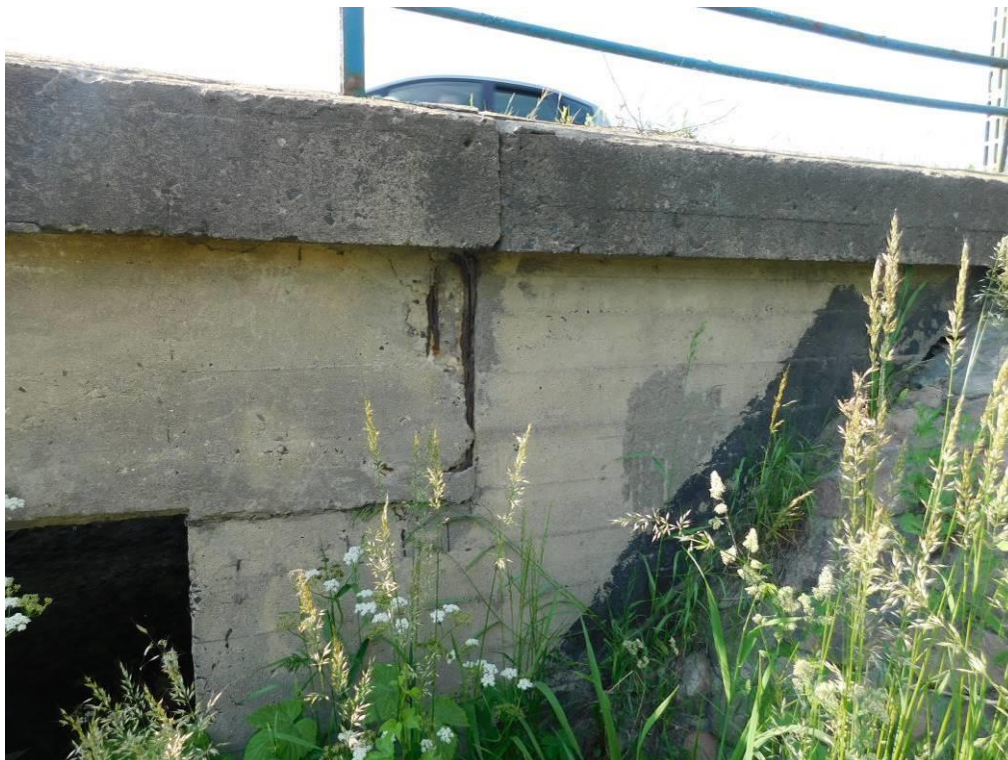
Fot. 17. Ubytek betonu i korozja odsłoniętego zbrojenia na bocznej powierzchni dźwigara płytowego - od górnej wody
