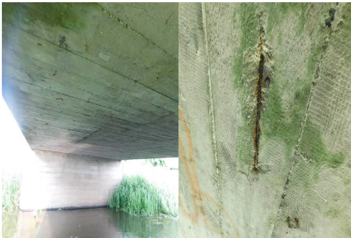
Fot. 15. Miejscowe ogniska korozji na spodzie dźwigara płytowego powstałe na skutek korozji zbrojenia i zbyt małej otuliny betonowej w tych miejscach
