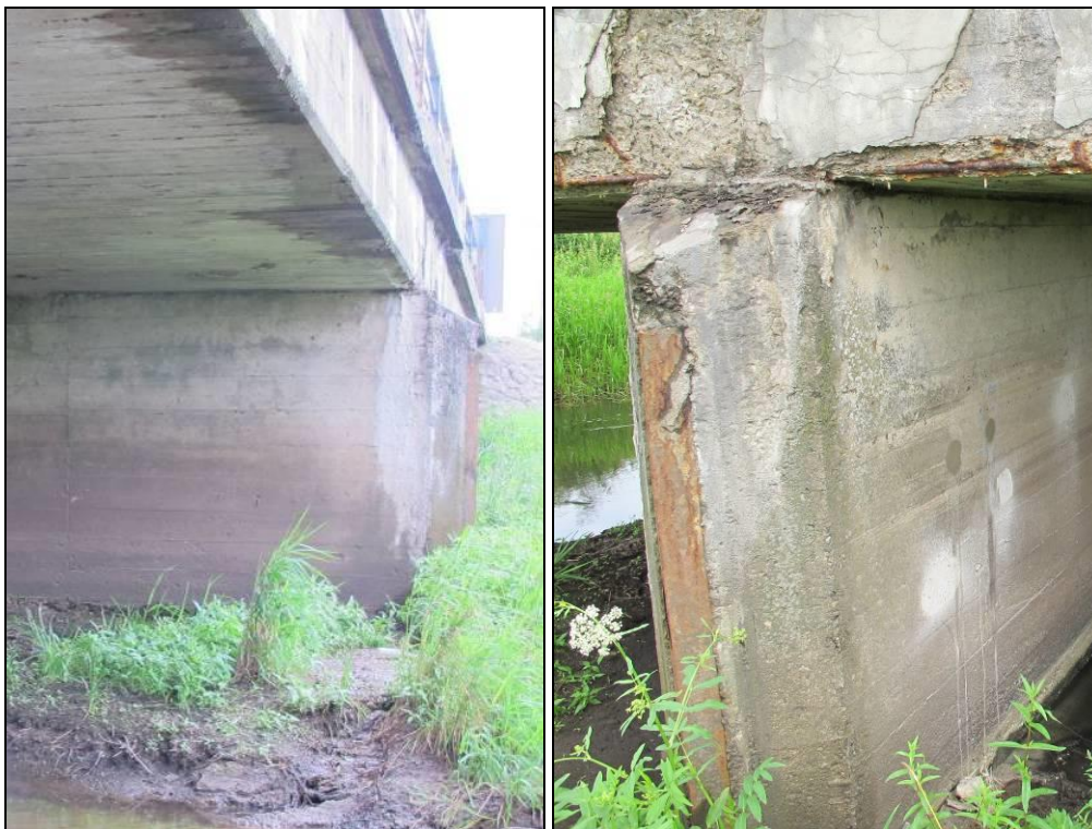
Fot. 19. Wapienne zacieki i osady oraz spękania i ubytki warstw powierzchniowych betonu na filarze pośrednim - od dolnej wody
