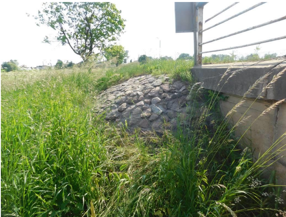
Fot. 20. Wegetacja roślinności na umocnieniu stożka skarpowego - od dolnej wody
