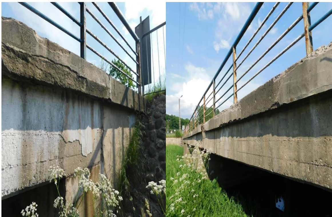
Fot. 13. Ubytki i spękania betonu na gzymsie oraz na bocznej powierzchni dźwigara płytowego - od dolnej wody
