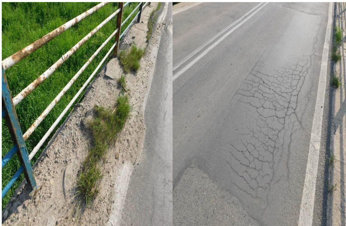
Fot. 10. Ubytki i spękania betonu oraz odsłonięte korodujące zbrojenie w belce podporęczowej. Wegetacja roślinności i zanieczyszczenia wzdłuż belki podporęczowej. Zniszczenie powłok ochronnych na balustradach wraz z towarzyszącymi im ogniskami korozji, spękania nawierzchni - od strony GW
