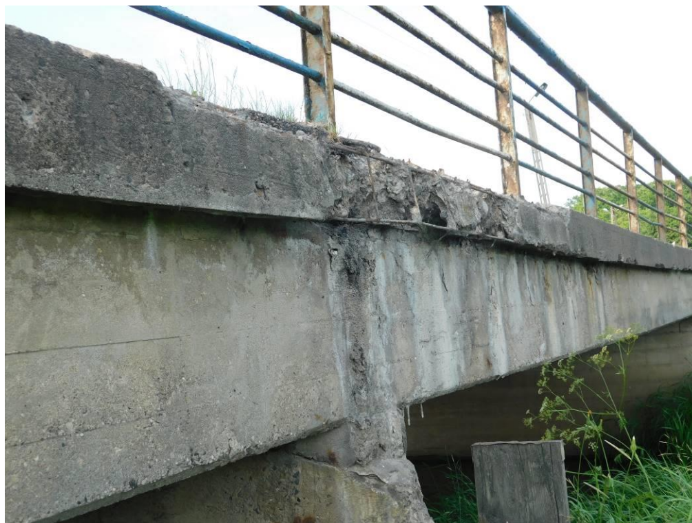
Fot. 14. Zacieki i wykwyty wapienne na bocznej powierzchni dźwigara płytowego - od górnej wody
