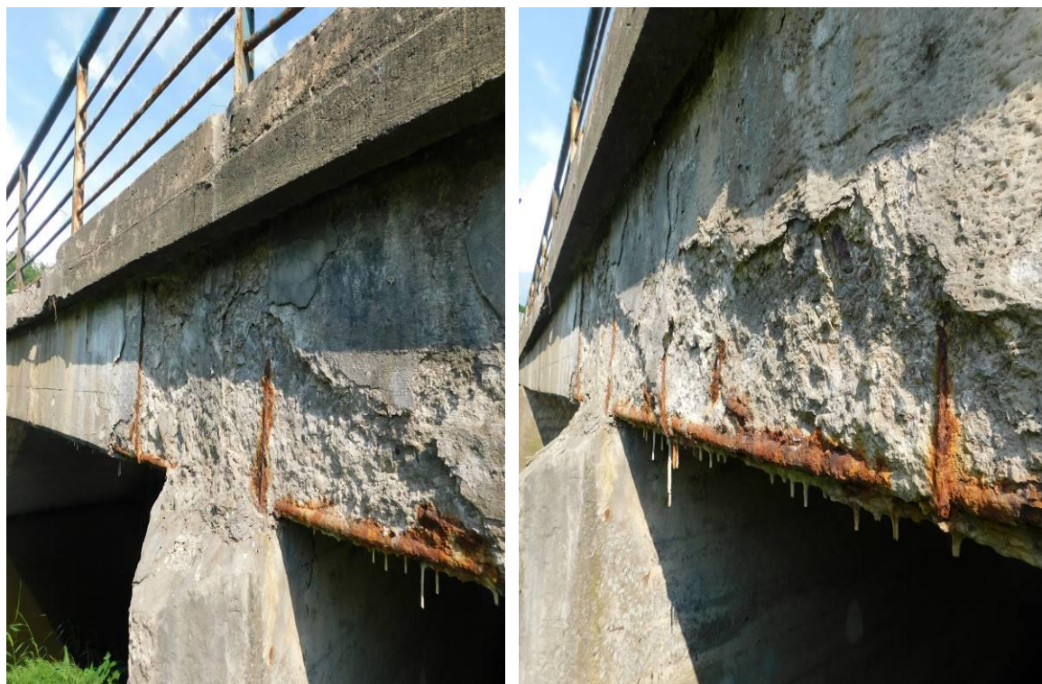
Fot. 16. Ubytek betonu oraz odsłonięcie i korozja wkładek zbrojeniowych dźwigara płytowego w obrębie podpory pośredniej.
