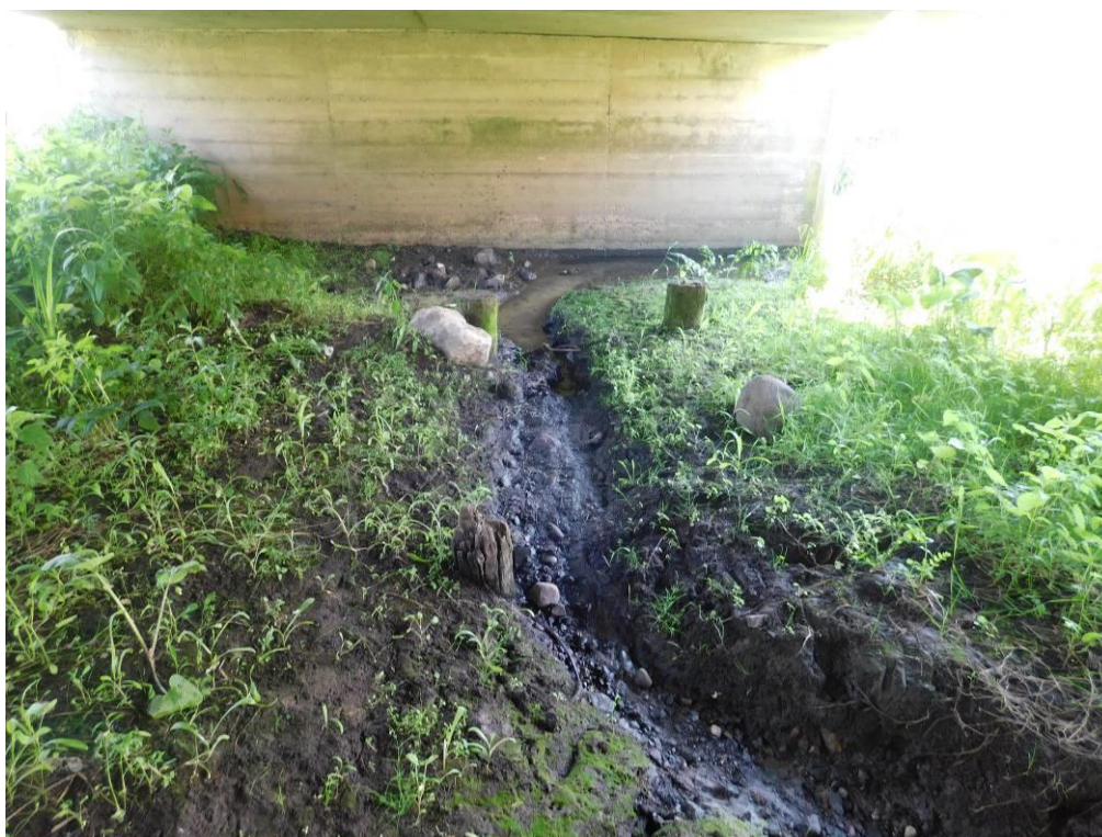
Fot. 22. Przemieszczenia i wypłukania gruntu pod obiektem przez wodę opadową spływającą ze skarp przyobektowych. Widoczne zanieczyszczenia i wegetacja roślinności pod i w otoczeniu obiektu.
