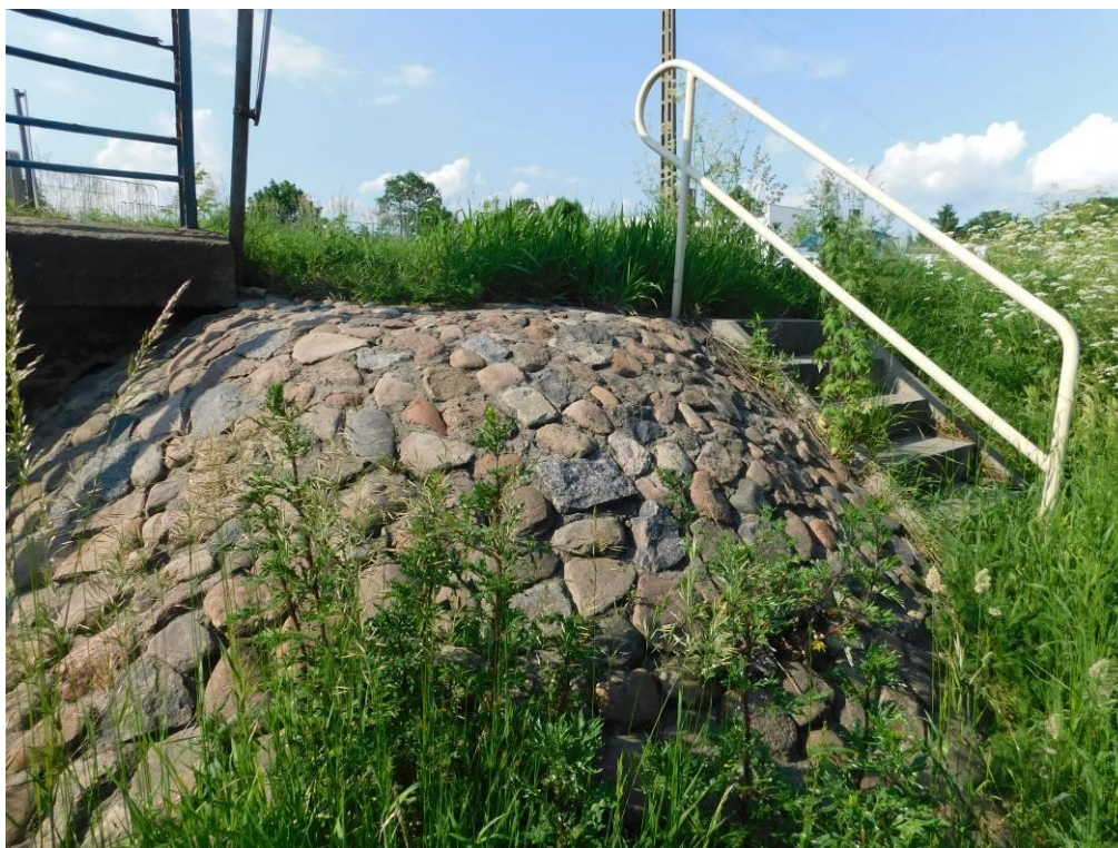
Fot. 21. Wegetacja roślinności na umocnionym stożku skarpowym oraz schodach skarpowych – widok od dolnej wody
