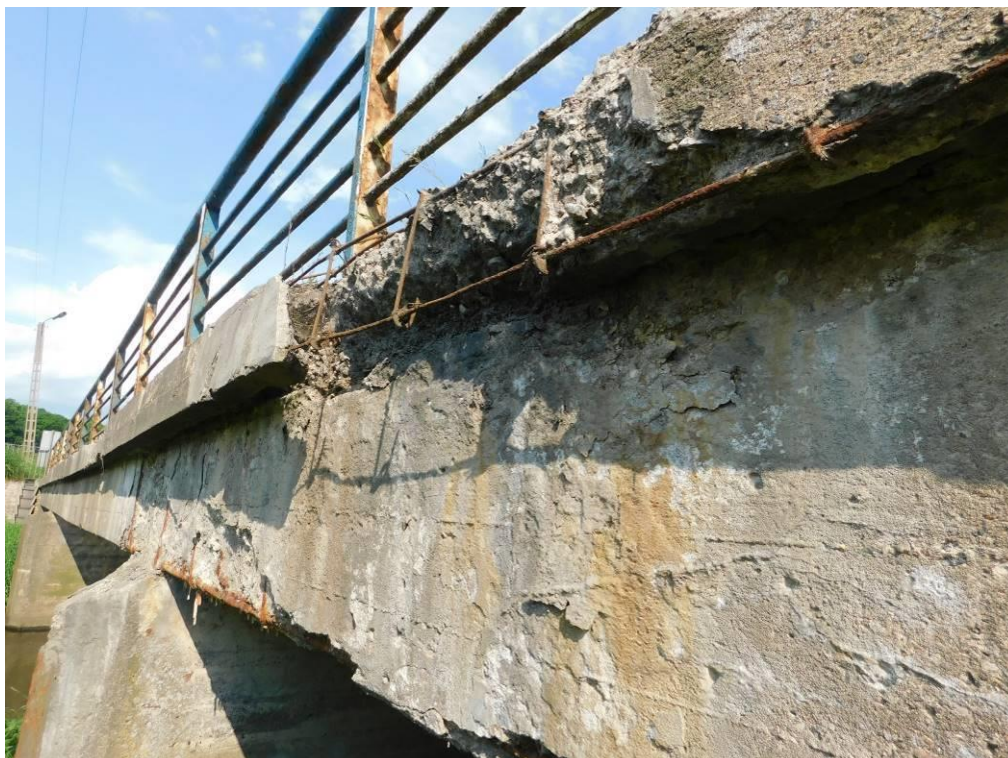
Fot. 18. Ubytki betonu z odsłoniętymi prętami zbrojeniowymi, rozległe zacieki wraz z wapiennymi wykwitami na bocznej powierzchni dźwigara płytowego oraz na gzymsie (brak fragmentu gzymsu) - od górnej wody
