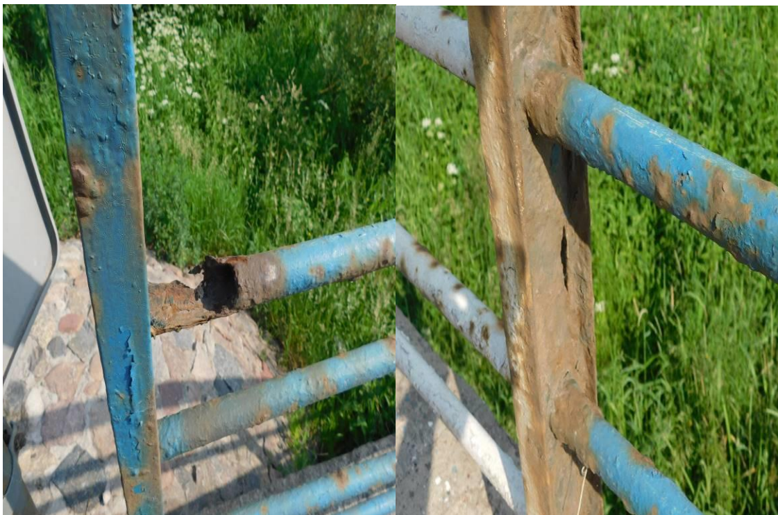
Fot. 8. Zniszczenie powłoki antykorozyjnej, korozja wżerowa z perforacją na stalowych elementach balustrad - od strony Kuluszek od DW
