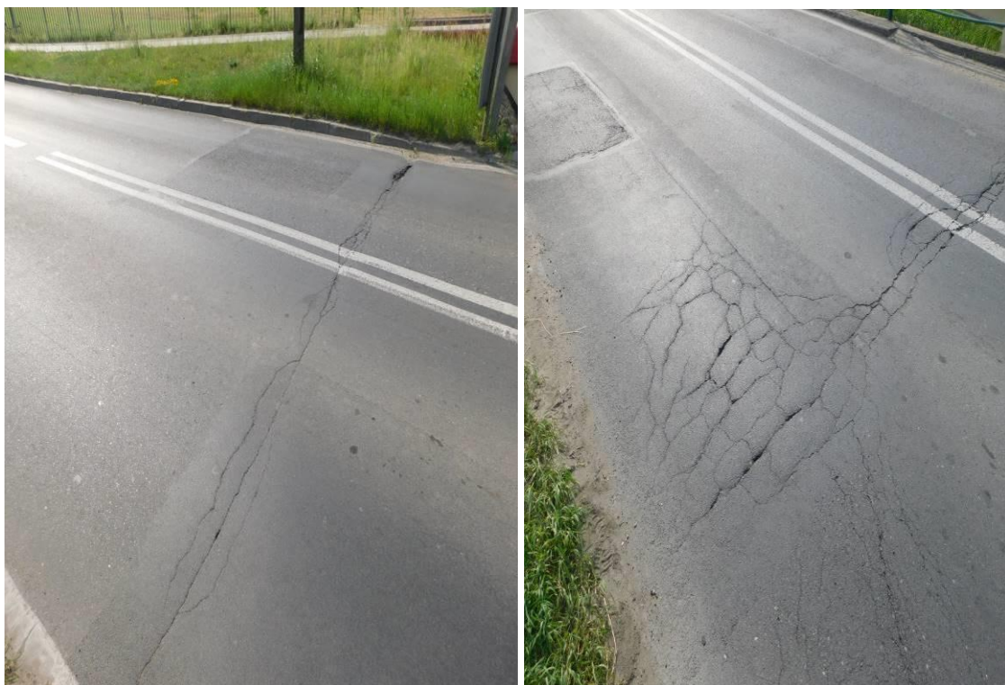
Fot. 5. Poprzeczne pęknięcie nawierzchni na dojeździe (na końcu skrzydła) powstałe na skutek zmiany sztywności podbudowy drogi – zdjęcie lewe. Spękania i zaniżenia nawierzchni jezdni na dojeździe – zdjęcie prawe. Dojazd od strony Piotrkowa Trybunalskiego
