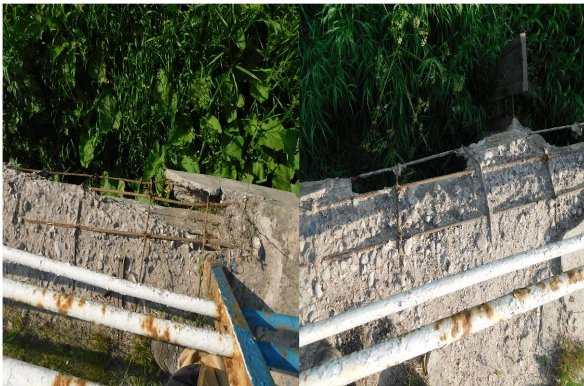
Fot. 12. Ubytki betonu belek podporęczowych oraz gzymsów wraz z odsłoniętym i korodującym zbrojeniem - od strony GW zdjęcie po lewej, od strony DW zdjęcie po prawej
