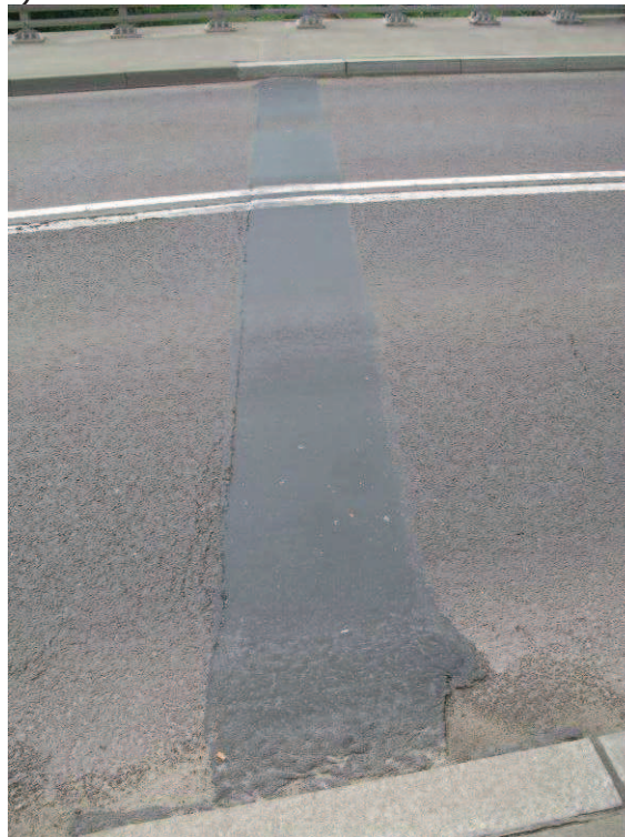
Fot. 9. Spękania i ubytki nawierzchni jezdni na dojeździe przy szczelinie dylatacyjnej, deformacje masy zalewowej w bitumicznym przykryciu dylatacyjnym a) po stronie Poddębic b) po stronie m. Piątek
