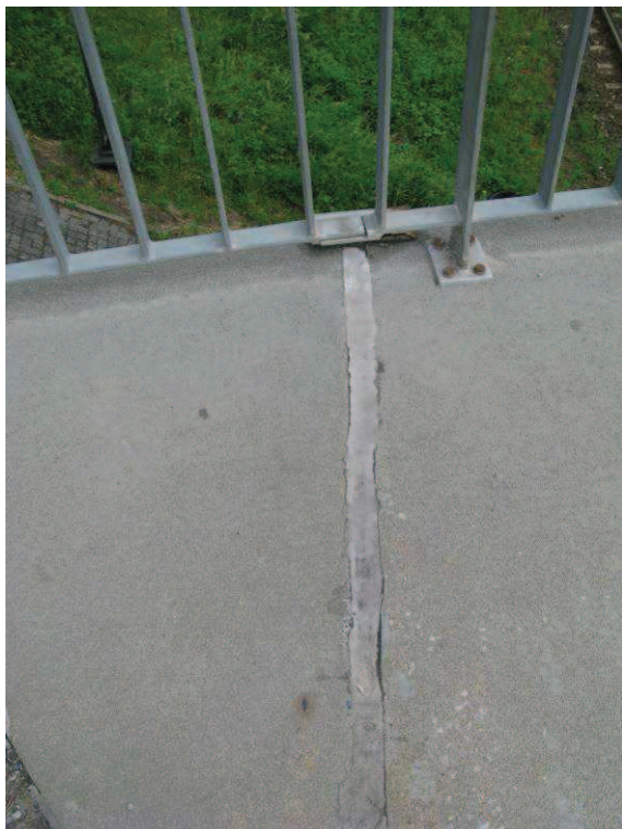
Fot. 20. Miejscowe ubytki i deformacja masy plastycznej wypełniającej szczelinę dylatacyjną oraz korozja blachy osłaniającej szczelinę dylatacyjną na gzymsie – chodnik lewy, dylatacja po stronie Poddębic
