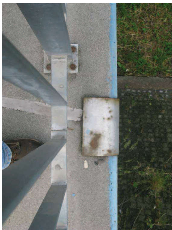
Fot. 21. Miejscowe ubytki i deformacja masy plastycznej wypełniającej szczelinę dylatacyjną oraz korozja blachy osłaniającej szczelinę dylatacyjną na gzymsie – chodnik prawy, dylatacja po stronie Poddębic
