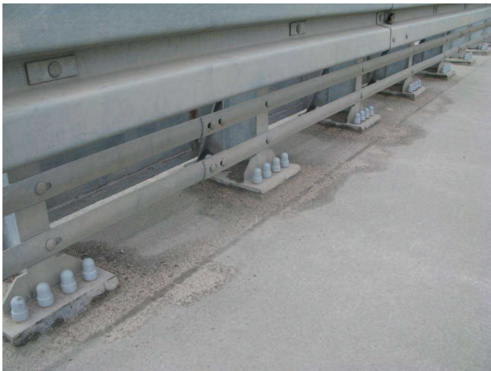
Fot. 15. Zanieczyszczenia chodnika materiałem ziemnym w rejonie słupków barieroporęczy – uszkodzenia tożsame dla całego obiektu
