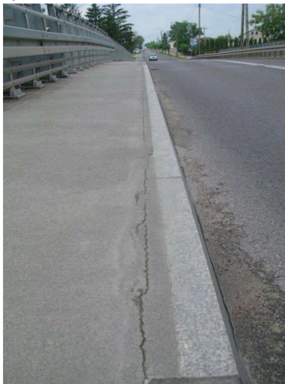
Fot. 13. Pęknięcie nawierzchni chodnika na obiekcie o charakterze technologicznym ponieważ nawierzchnię ułożono na krawężniku - a) chodnik lewy b) chodnik prawy
