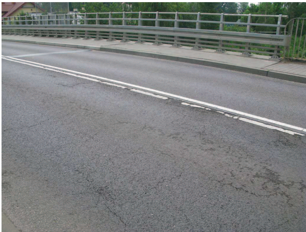
Fot. 8. Siatki spękań, podłużne rysy i deformacje w postaci kolein na nawierzchni jezdni na dojeździe od strony Poddębic
