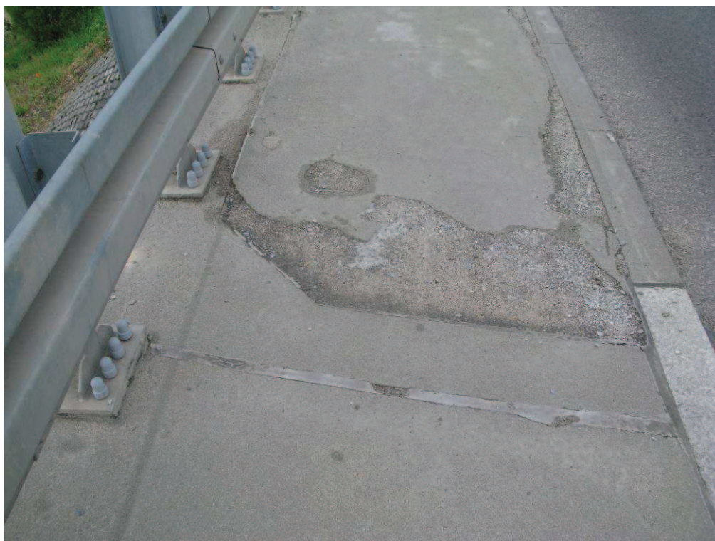
Fot.16. Zanieczyszczenia oraz spękania i ubytki nawierzchni w obrębie prawego chodnika na dojściu od Poddębic
