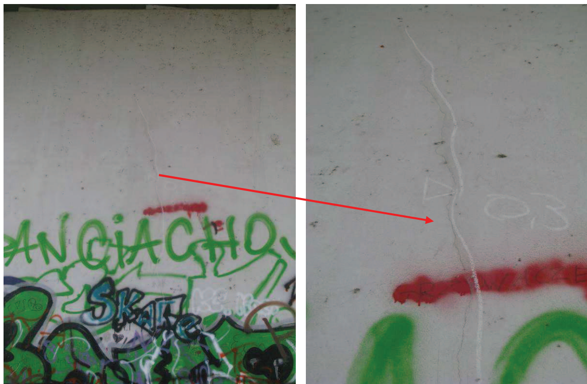
Fot. 29. Rysa na korpusie przyczółka P2 o rozwarości 0,3 mm
