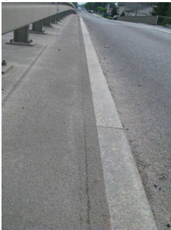
Fot. 13. Pęknięcie nawierzchni chodnika na obiekcie o charakterze technologicznym ponieważ nawierzchnię ułożono na krawężniku - a) chodnik lewy b) chodnik prawy
