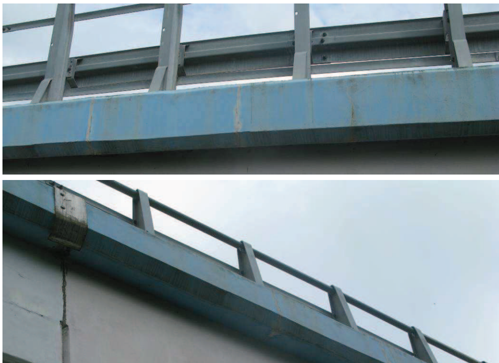
Fot. 17. Rysy, zacieki, wapienne osady na belkach gzymsowych po prawej stronie obiektu
