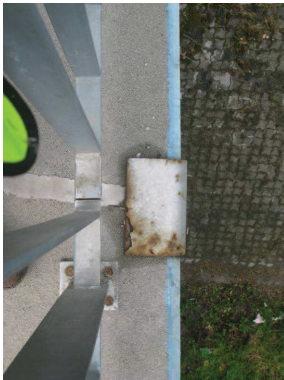
Fot. 20. Miejscowe ubytki i deformacja masy plastycznej wypełniającej szczelinę dylatacyjną oraz korozja blachy osłaniającej szczelinę dylatacyjną na gzymsie – chodnik lewy, dylatacja po stronie Poddębic
