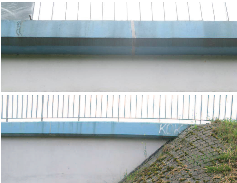
Fot. 18. Rysy, zacieki, wapienne osady na belkach gzymsowych – widok z lewej strony
