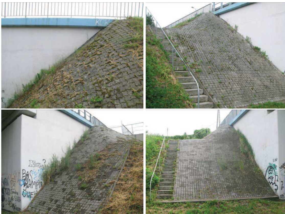
Fot. 31. Wegetacja roślinności na brukowaniu stożków skarpowych i na schodach rewizyjnych na skarpach
