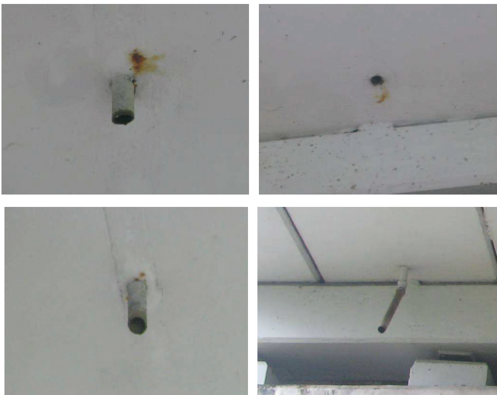
Fot. 19. Sączki odwadniające pomost – miejscowe rdzawe wykwit na powierzchni dźwigarów, powierzchniowa korozja i lokalne ubytki materiału na rurach sączków
