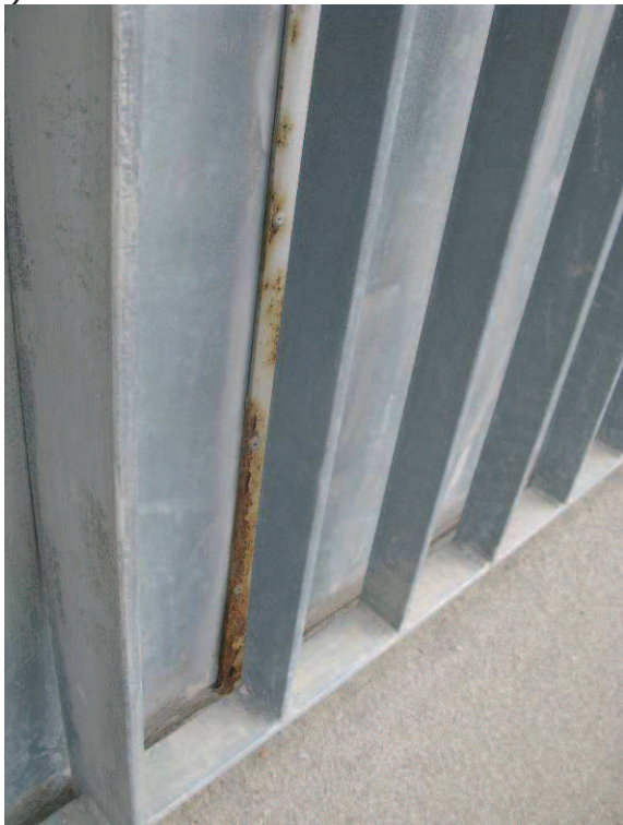
Fot. 23. a) Lokalna korozja wżerowa na elementach osłon przeciwporażeniowych b) Lokalne powierzchniowe zanieczyszczenia pochwyty balustrady powstałe w wyniku wandalizmu
