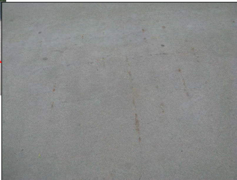
Fot. 14. Rdzawe wykwity na nawierzchni lewego chodnika, w rozstawie ok. 20 cm, jako skutek korozji zbrojenia kapy chodnikowej
