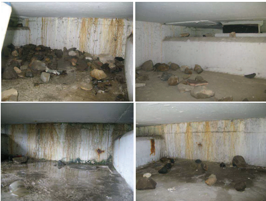
Fot. 30. Wapienne i rdzawe zacieki z osadami na ścianach zapleczych i niszach podłożyskowych obu przyczółków powstałe w wyniku nieszczelności dylatacji. Zanieczyszczenia niszy podłożyskowej powstałe w wyniku wandalizmu
