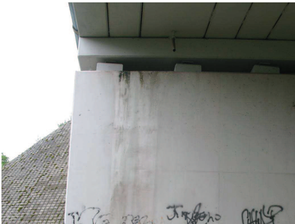
Fot. 28. Zacieki na korpusie przyczółka P1 z niszy podłożyskowej
