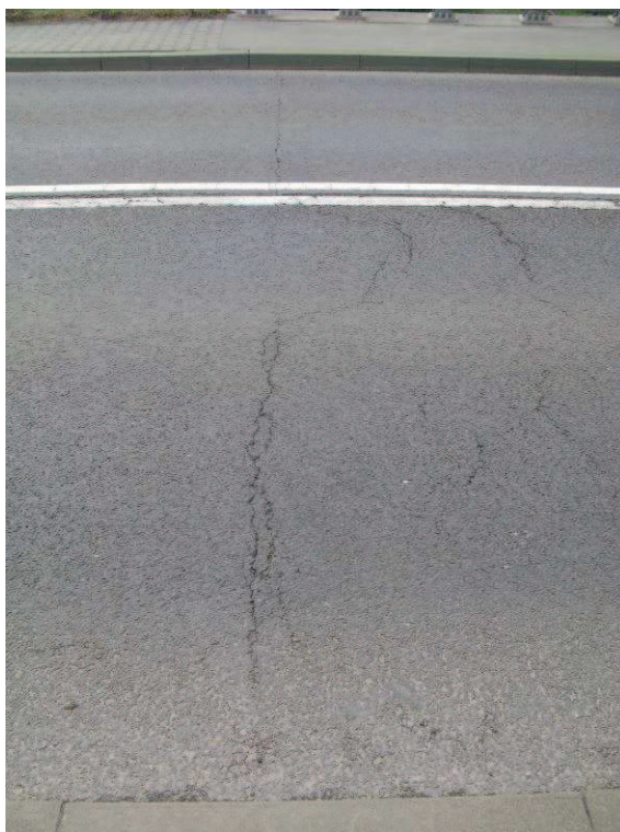
Fot.10. Spękania poprzeczne nawierzchni jezdni na dojeździe od strony m. Piątek
