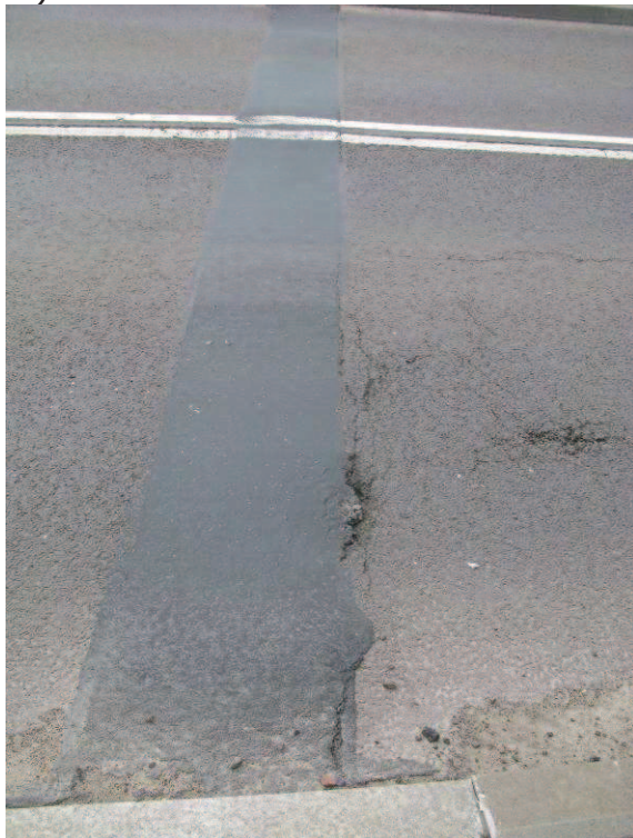
Fot. 9. Spękania i ubytki nawierzchni jezdni na dojeździe przy szczelinie dylatacyjnej, deformacje masy zalewowej w bitumicznym przykryciu dylatacyjnym a) po stronie Poddębic b) po stronie m. Piątek
