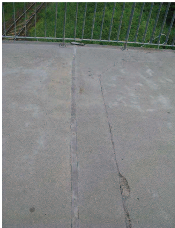
Fot. 21. Miejscowe ubytki i deformacja masy plastycznej wypełniającej szczelinę dylatacyjną oraz korozja blachy osłaniającej szczelinę dylatacyjną na gzymsie – chodnik prawy, dylatacja po stronie Poddębic
