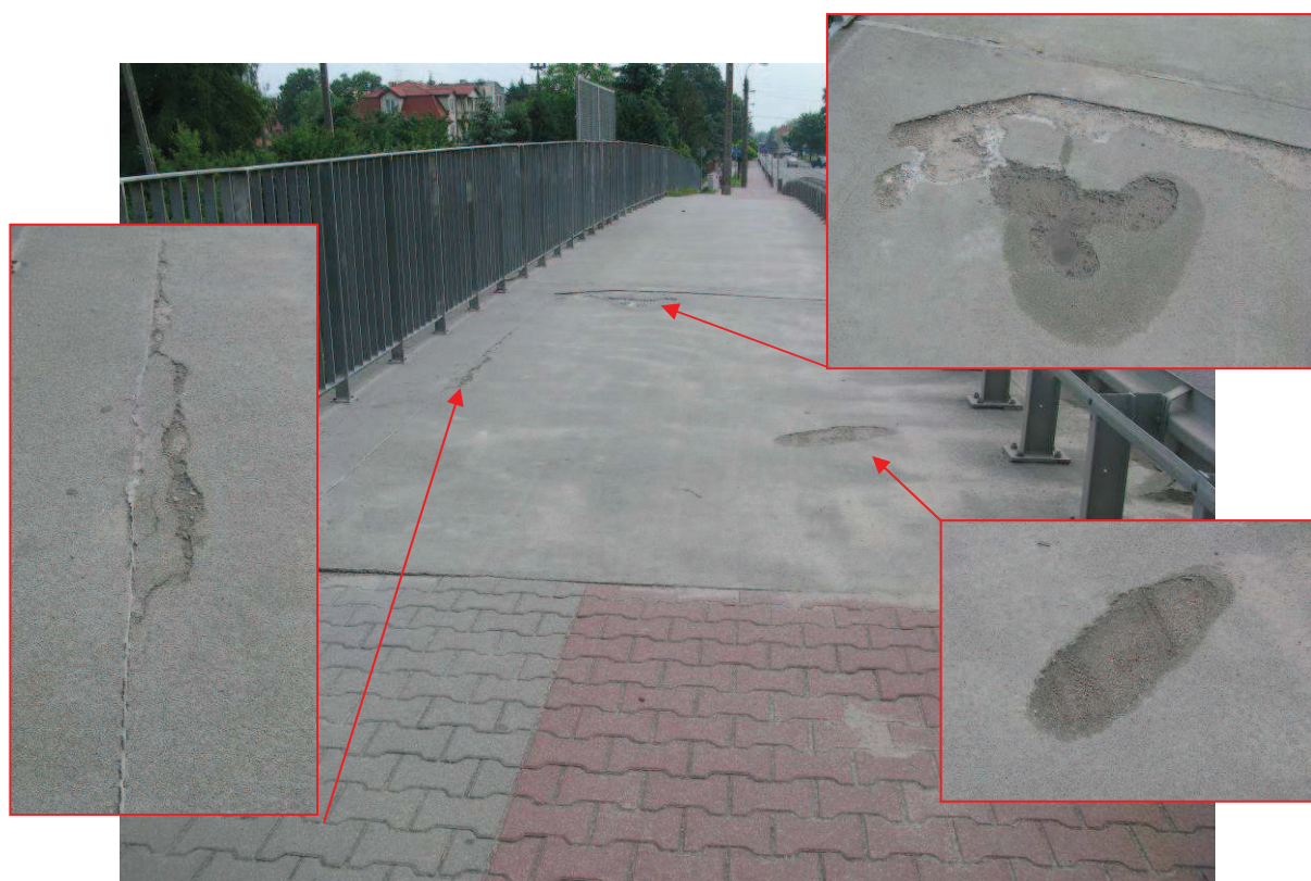
Fot. 11. Zanieczyszczenia oraz spękania i ubytki nawierzchni w obrębie lewego chodnika na dojeździe od Poddębic
