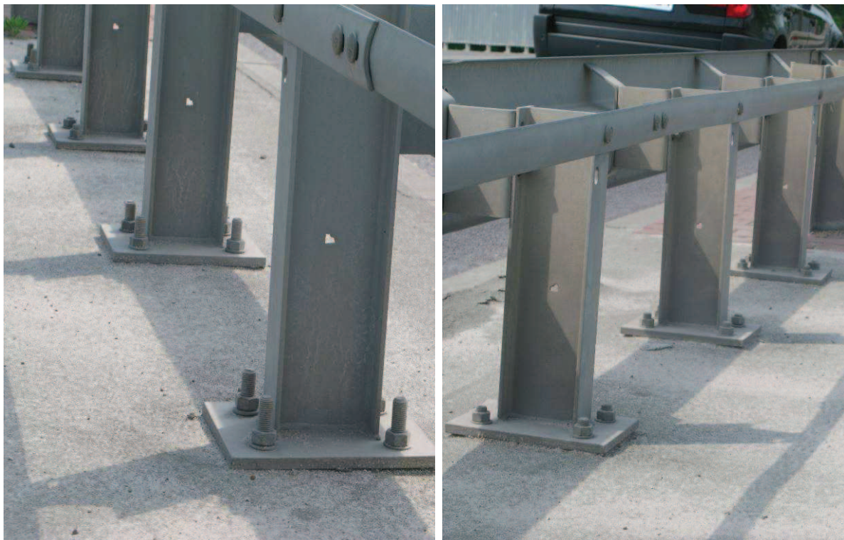
Fot. 22. Lokalne ubytki osłon na śrubach mocujących słupki barier energochłonnych oraz spękania i ubytki podlewek pod stopami słupków na lewym chodniku w obrębie skrzydeł przyczółków
