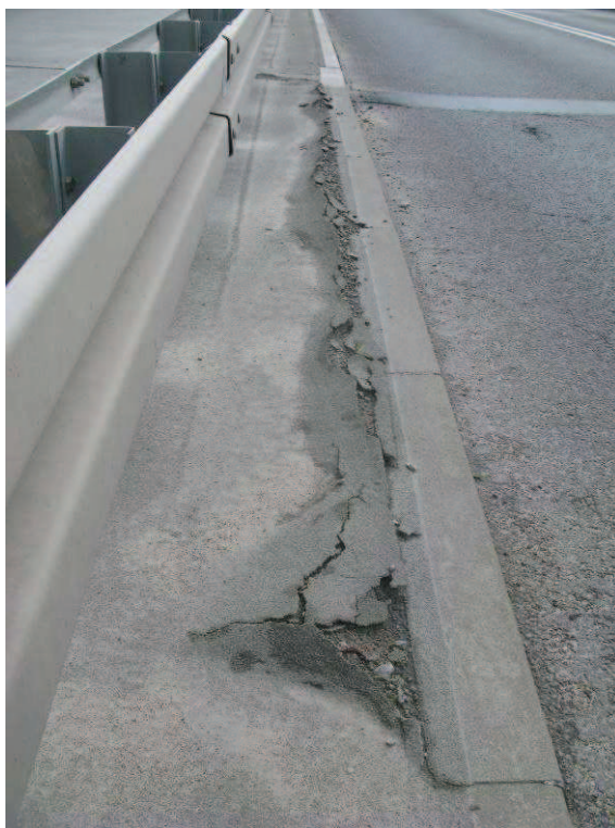
Fot. 12. Spękania i ubytki nawierzchni lewego chodnika w strefie przykrawężnikowej na dojeździe od strony Poddębic
